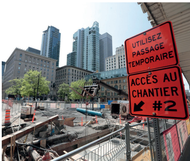
↑ Aménagement des cheminements piétons, chantier de la rue Sainte-Catherine, Montréal.
