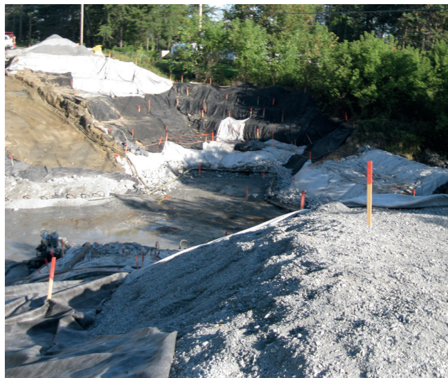
↑ Chantier à Ste-Hélène de Bagot
