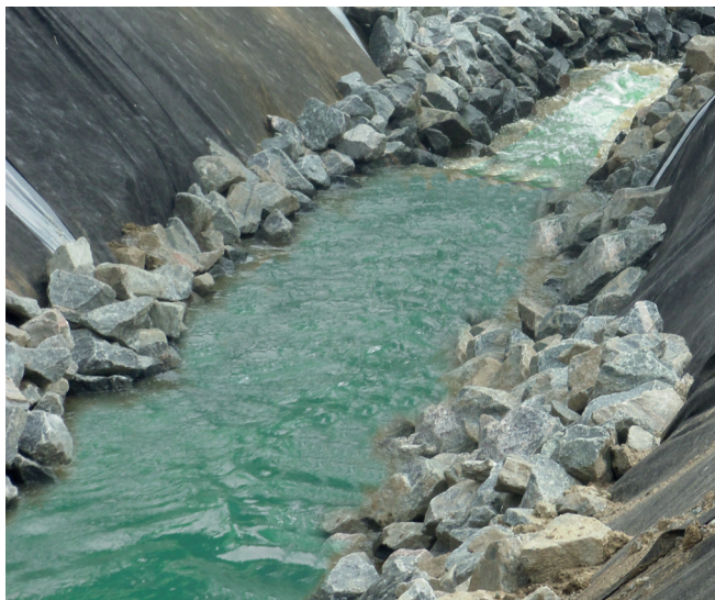
↑ Chantier à Ste-Geneviève-de-Batiscan.
