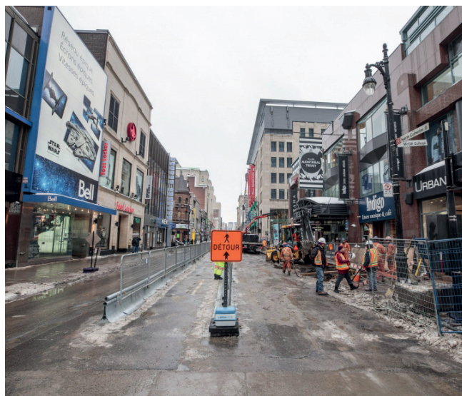
↑ Maintien des accès aux habitations et commerces, chantier de la rue Sainte-Catherine, Montréal.
