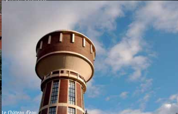
Le Château d'eau
